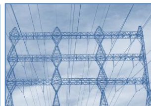
Transmissão em Ultra Alta Tensão
